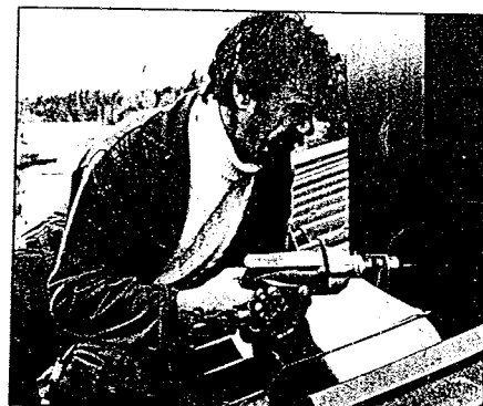
18. Lyft manteln över rökröret och skjut på den över beslagen. Loda upp manteln med vattenpass. Borra för plåtskruv (Ø 3,5 mm) genom mantelns nederdel och beslagsstosar. Vid skorstenshöjder över 2 meter borrar Du två rader med tre hål per skorstenssida. Skruva fast manteln med medföljande plåtskruvar.
