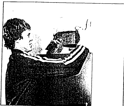
10. Montera den första rökkanalsmodulen i stosen. För att undvika repor på Futura bör denna under monteringen täckas in med ex. papper eller dylikt.
