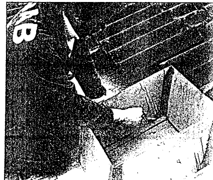
3. Loda upp centrum på rökkanalen/schaktet och markera i yttertaket var den skall gå igenom. Rita in hålet efter underbeslagets stös. OBS! Såga upp hålet 2 cm större än markeringen (runt om).
