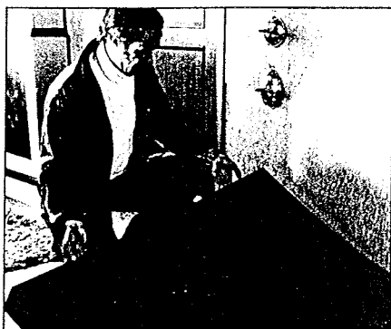
7. Lagg ut golvplåten över fiberunderlägget. Kanterna jämnar Du med kniv. Montera en "nivå-täcklist" runt plåten. Den ingår ej i leveransen.
