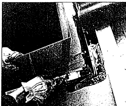
5. Spika fast underbeslaget i avväxlingarna med medföljande kamspik. Här är det viktigt att Du får tätt mellan underbeslag och undertak. Använd elastiskt kitt, tätningssmassa eller dylikt.
